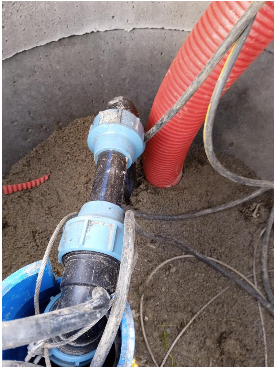
Vue de l'intérieur du citerneau
